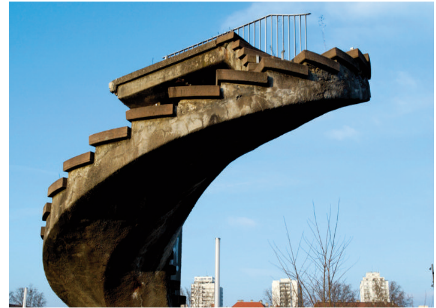
Fig. 8 Scala elicoidale del viadotto Churchill, Strasburgo.
