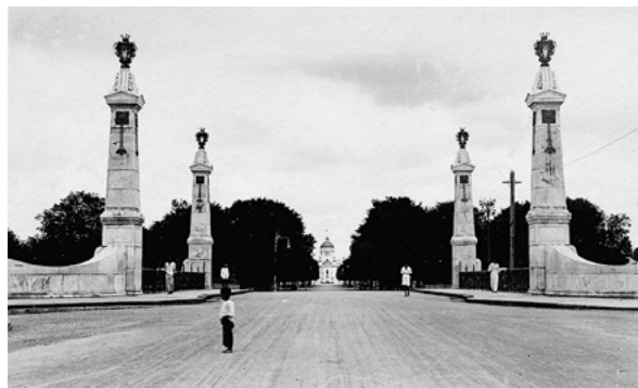
Fig. 6 | Una veduta della Ratchadamnoen Road dal ponte Pi Pob Li La, sullo sfondo la Sala del Trono AnantaSamakhom.
